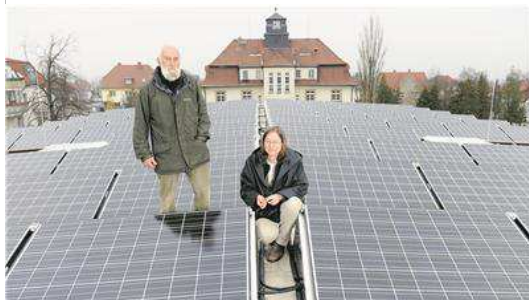
Umgeben von Solarmodulen sind Silke Sesterhenn und Lutz Gaber vom Bürgerkraftwerk nur auf dem Turnhallendach in Weixdorf. In Dresden gibt es im Vergleich zum Bundesdurchschnitt noch relativ wenige Solaranlagen. Für regionale Betreiber wird es jetzt komplizierter. Foto: Steffen Unger
